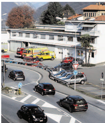
CASERMA Da lasciare a metà estate 2012 in vista dell'edificazione del nuovo Centro di pronto intervento. (Foto Maffi)
